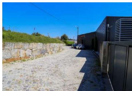
Travessa do Mosteiro de Singeverga
